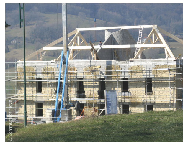
La Maison des Sœurs lors des travaux
